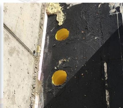
**diboFLEX** Handelsübliche RDS-Systeme für Kabeldurchführungen sind integrierbar. Der Spacer aus Polystyrol schafft Platz für den Anschluss z.B. von KG-Rohren.
