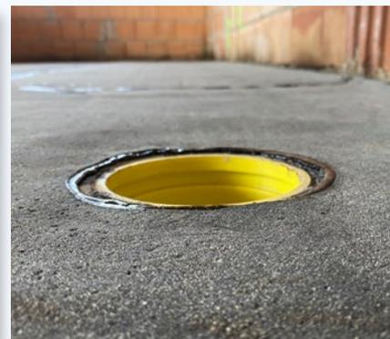
**diboFLEX** bietet höchste Dichtheit, weil einbetonierbar und direkt mit den Bitumenbahnen verschweißbar. Bei Keller-Außenwänden sind auch verschiedene Bitumen-Dickanstriche (1K / 2K) verwendbar. Im Gesamtprozess einer Rohrdurchführung ergeben sich erhebliche Kosteneinsparungen.
