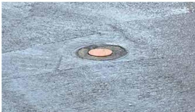
diboFLEX wird niveaugleich mit den Bitumenbahnen verschweißt, dadurch entsteht Sicherheit und „Einteiligkeit“ der Dichtebenen innerhalb der „Schwarzen Wanne“.
